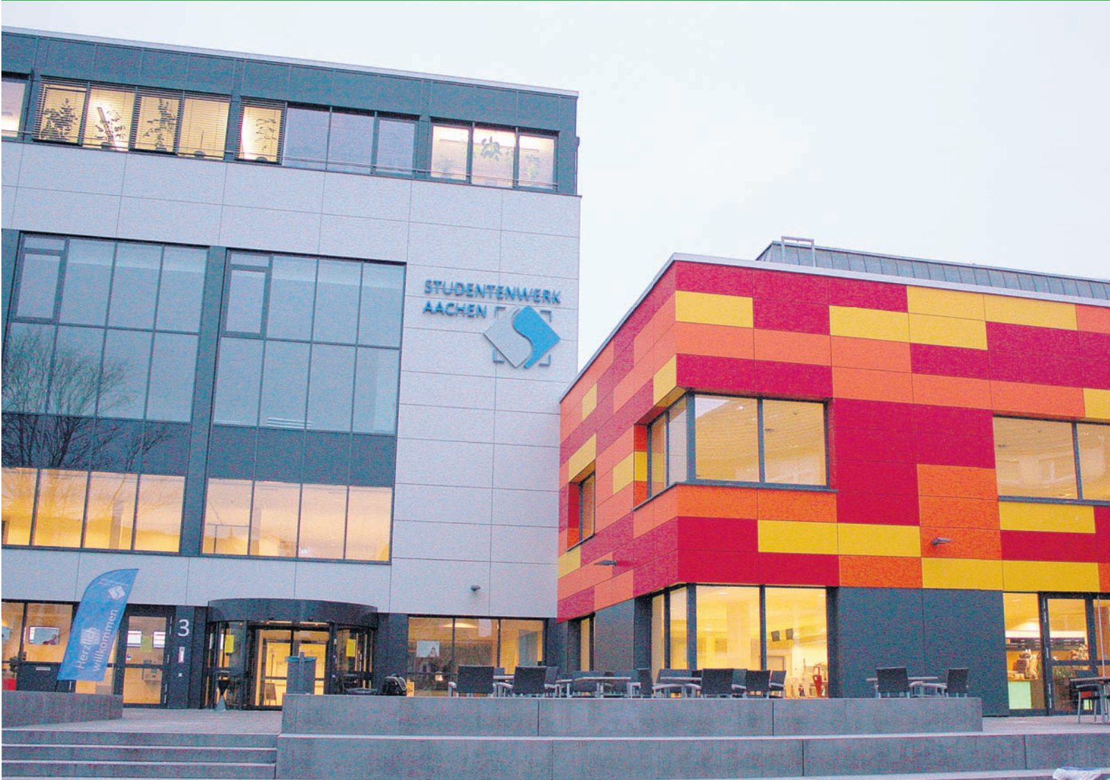
Nach einer Kernsanierung sind die alten Strukturen in der neuen Mensa noch erkennbar. Der Raum wurde jedoch besser ausgenutzt und durch die Optimierung der Küchenprozesse ließen sich auch die Sitzplätze von 1.000 auf 1.470 erhöhen, um 6.500 Tischgäste täglich bedienen zu können. Im 1. Obergeschoss des Mittelteils sorgen Lichtkuppeln für eine freundliche Atmosphäre im Freeflowbereich. Foto: Maxi Scherer/CM
