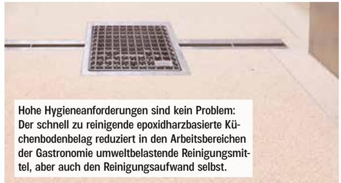
Hohe Hygieneanforderungen sind kein Problem: Der schnell zu reinigende epoxidharzbasierte Küchenbodenbelag reduziert in den Arbeitsbereichen der Gastronomie umweltbelastende Reinigungsmittel, aber auch den Reinigungsaufwand selbst.
